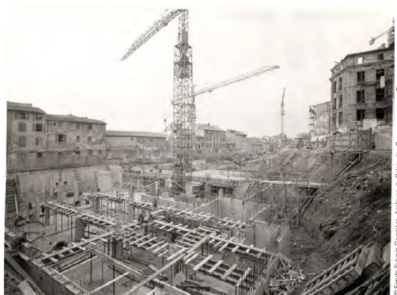
Fig. 5 Construction du parking souterrain du quartier de la Balance, Avignon, janvier 1971
